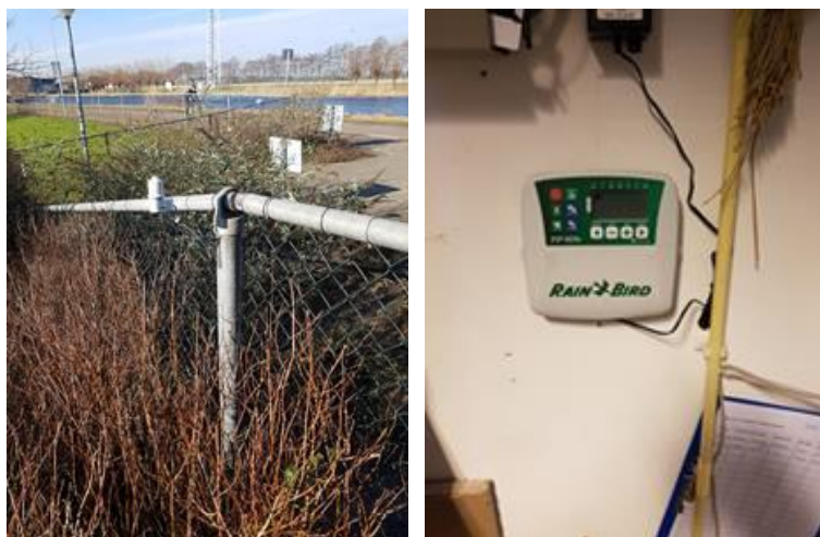
Regensensor op het hek rondom SAB terrein & de 'rainbird' die de irrigatie van de beplanting regelt. Beplanting is in de pluscategorie aangelegd om indien toereikend in de toekomst CO 2 -e uitstoot te compenseren.
