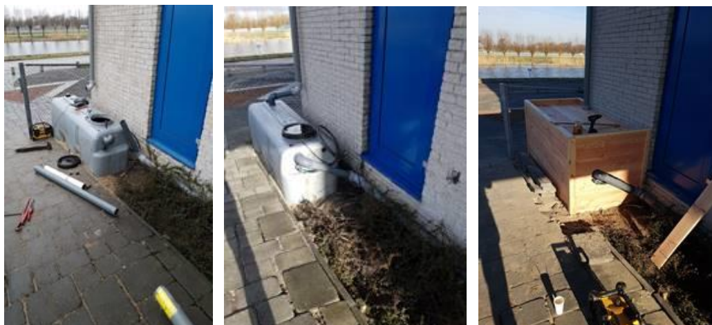
Grijswateropslagtank in verschillende stadia van afbouw
